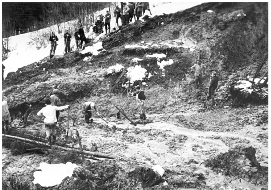
(Abb. 4: Helfer an der Abbruchstelle 1970.
