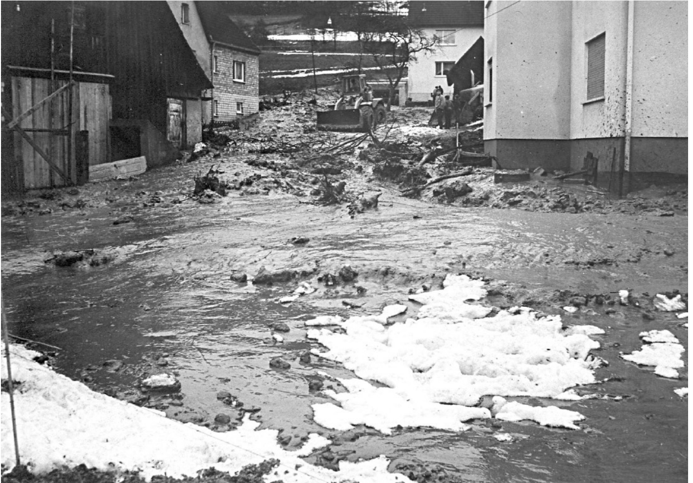
Abb. 3: Die verschüttete Mühlstraße 1970.
