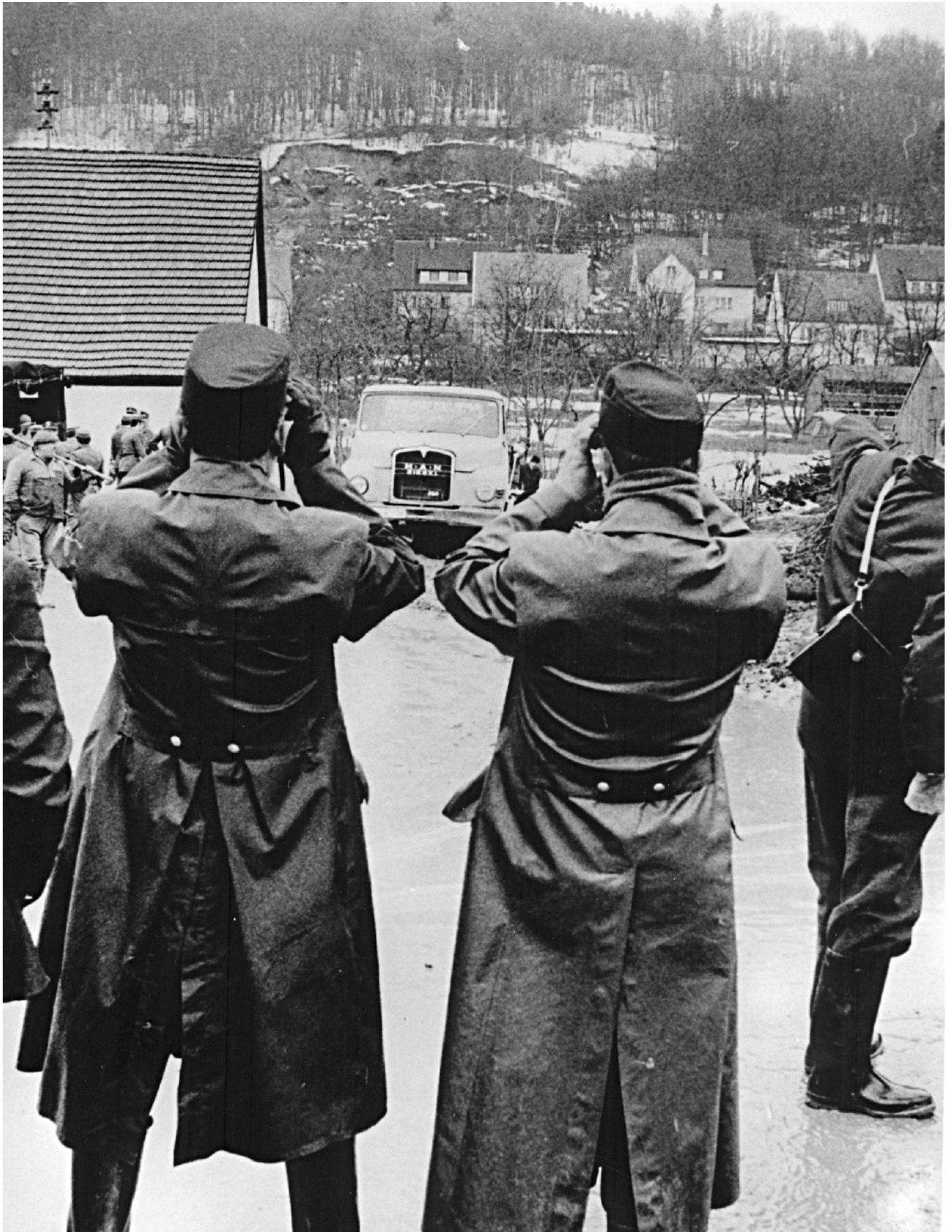
Abb. 1: Der abgebrochene Hang oberhalb der Mühlstraße 1970.
