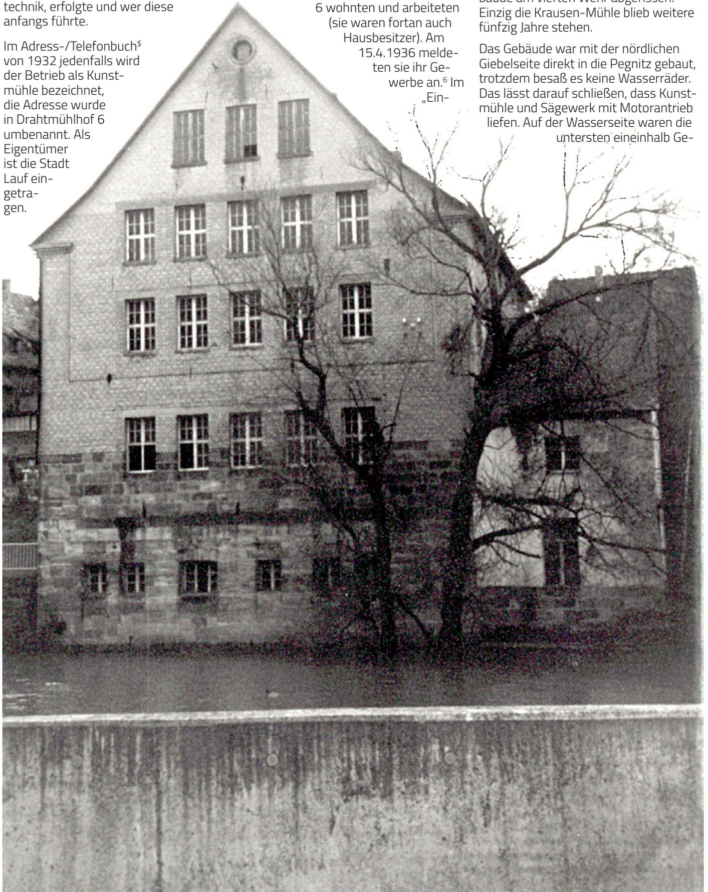
Abb. 2: Krausenmühle (Nordseite), 1988. Das Gebäude war auf einem älteren Untergeschoss aus Sandstein direkt in die Pegnitz gebaut.
