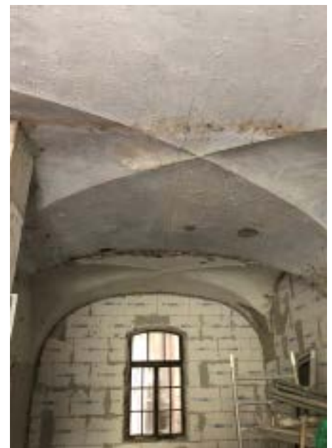
Abb. 22: Das Kreuzgratgewölbe im Erdgeschoss. Foto: Baldur Strobel
