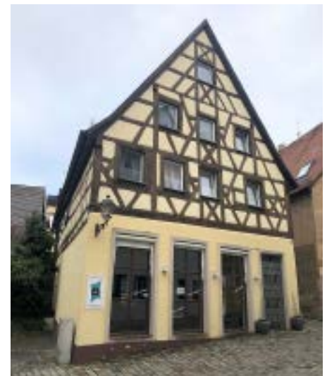
Abb. 8: Das Haus Burggasse 6. Foto: Baldur Strobel
