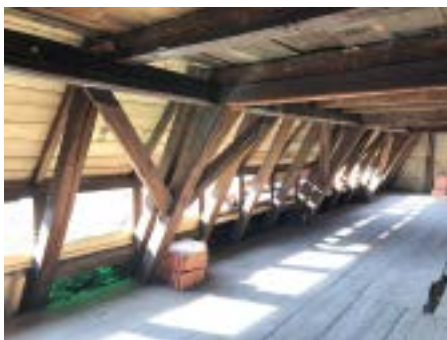
Abb. 19: Der Dachboden. Foto: Baldur Strobel
