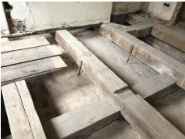
Abb. 23: Abgetragener Fußboden im 1. Obergeschoss mit Befestigung des Gewölbes. Foto: Baldur Strobel
