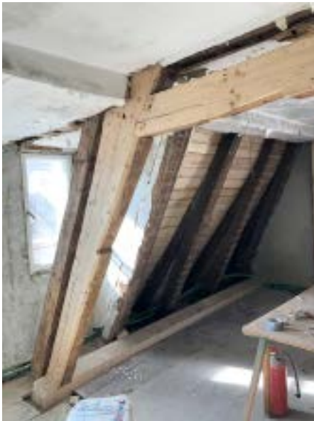
Abb. 18: Alte Balken mit Ergänzung. Foto: Baldur Strobel
