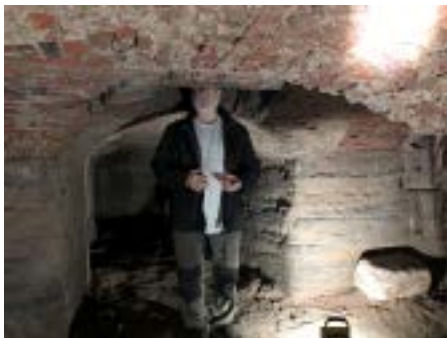
Abb. 10: Ein Luftschacht. Foto: Reinhard Deifel
