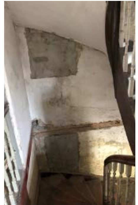
Abb. 20: Ehemaliges Fenster im Treppenhaus. Foto: Baldur Strobel
