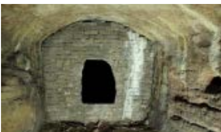
Abb. 5 Mauer mit Durchlass. Foto: Frank Zwanziger
