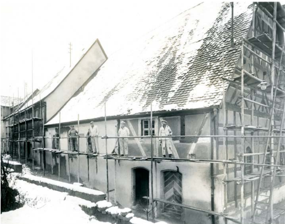
Abb. 7: Die arisierte Synagoge nach der Pogromnacht am 30. Januar 1939 während ihres Umbaus zum Heimatmuseum. Das Fachwerk wird freigelegt, entsprechend dem von der nationalsozialistischen Bauideologie damals bevorzugten „fränkischen Stils“.
