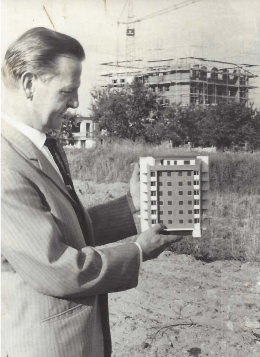
Abb.: 4. Dipl.-Ing. Klaus Hamann mit dem Modell des Hochhauses vor der Baustelle.
