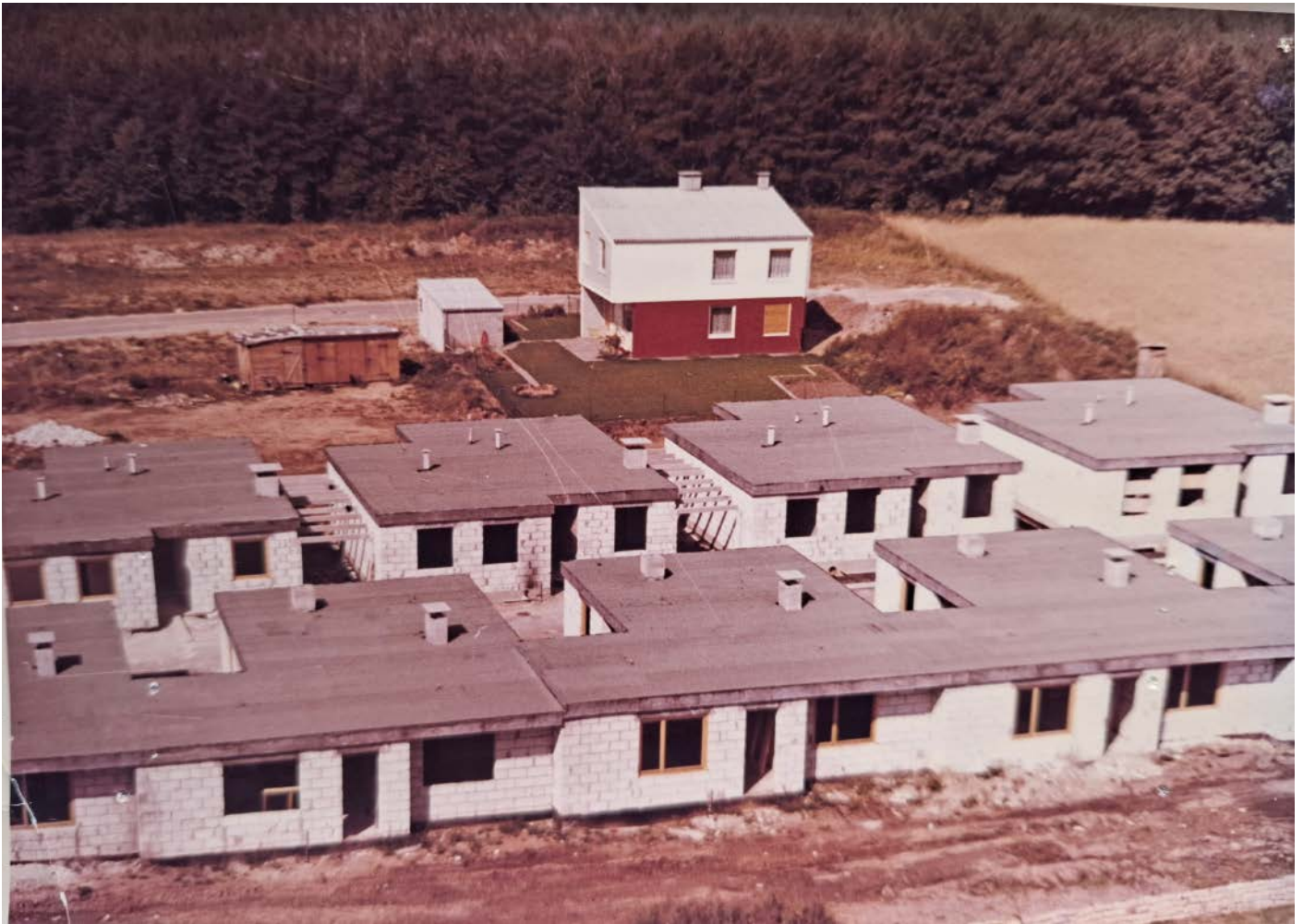
Abb. 10: Reihen- und Kettenbungalows im Rohbau, vermutl. Mai 1962.
