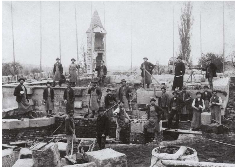
Unsere Kirche als Baustelle. Im Hintergrund die Abbruchspuren des Schlosses
