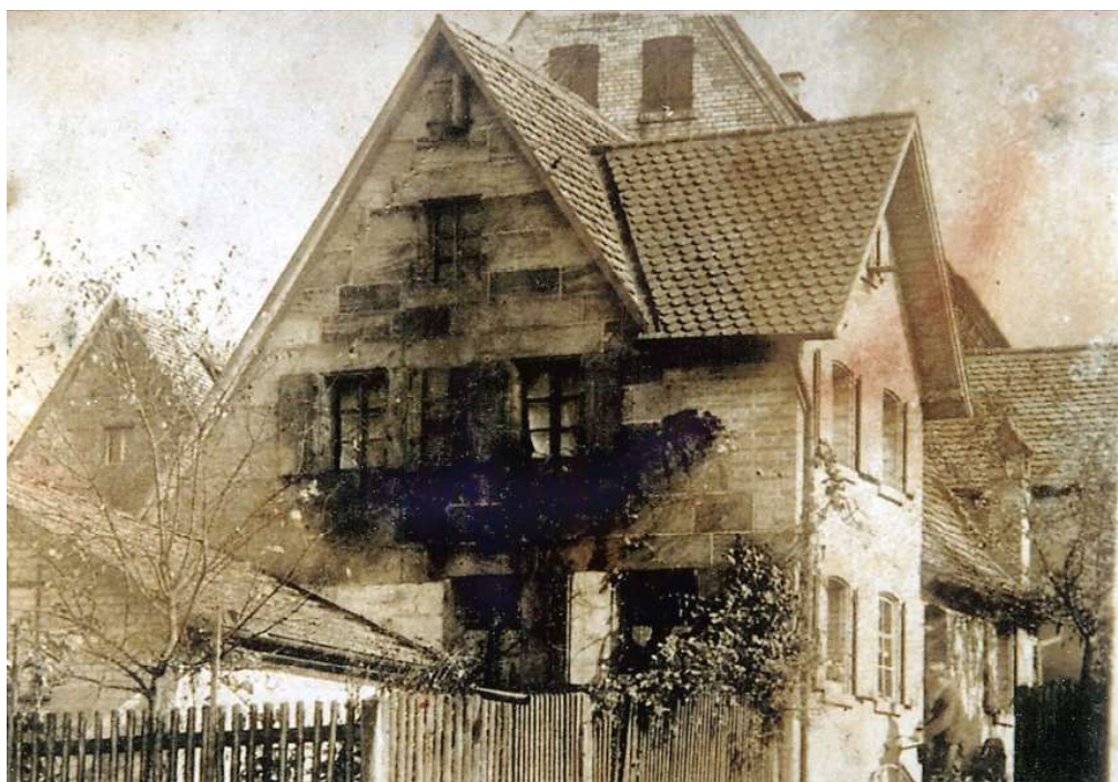
Das Haus Nr. 24 der Familie Hummel in der Bühlstr. 11 wurde in der Bombennacht zerstört. Ebenso die Häuser Nr. 25 der Fam. Wacker (rechts im Hintergrund) und Nr. 23 der Fam. Kettler (Giebel links im Hintergrund).
